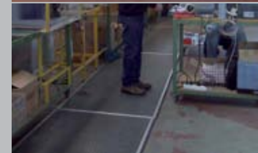
Teollisuuslaitoksiin asennettuja lämmitystasoja
